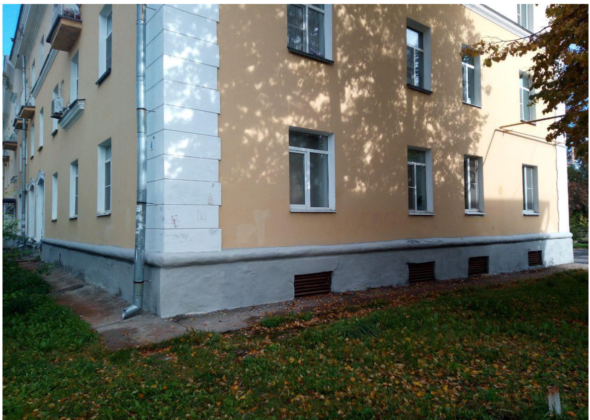
Ремонт цоколя (г. Волхов, ул.Профсоюзов д.5)
