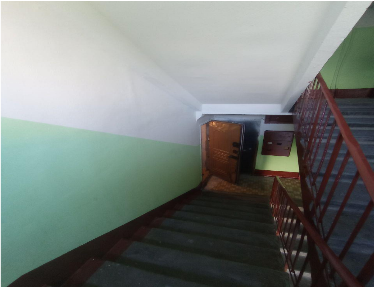
Ремонт подъезда после пожара (г. Волхов, ул. Ломоносова, д. 24)
